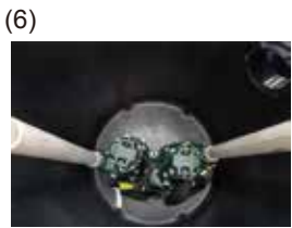
(6) 放置水泵，并用束带将电缆线固定在水管上，穿出上盖。
